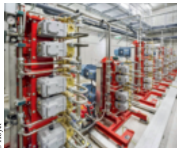
Hochdruckpumpen versorgen die Löschanlage des DC-Tower
