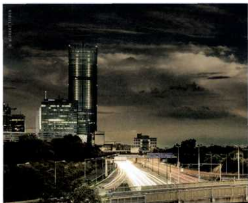
38 km Edelstahl-Rohrleitungen und 2 km Stahl-Rohre zwischen der Sprinklerzentrale und 230 m Höhe braucht es im DC Tower 1 alleine für die Löschanlage.
