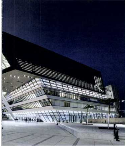
LLC Atrium: Die Raumhöhe des Atriums erforderte ein spezielles Löschkonzept, weshalb in diesem Bereich eine Sprühflutanlage geplant wurde.
