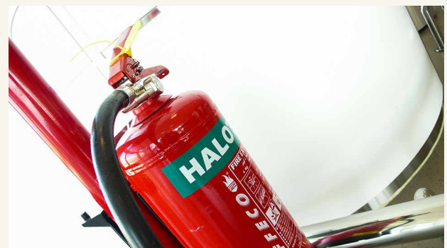
HALOTRON Feuerlöscher am Flughafen Doha (Katar).
